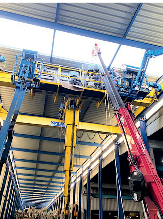
3 Um dem Platzmangel beim Retrofit unter dem Dach zu begegnen, setzte Kasto drei Gelenkheber sowie einen Autokran ein und öffnete zeitweise die Decke in Halle 9
